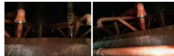
图3 清洗后罐内图像
