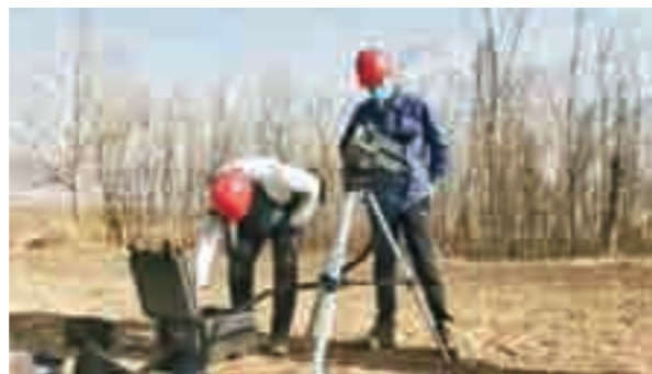
专业人员正在调试“激光炮”设备
